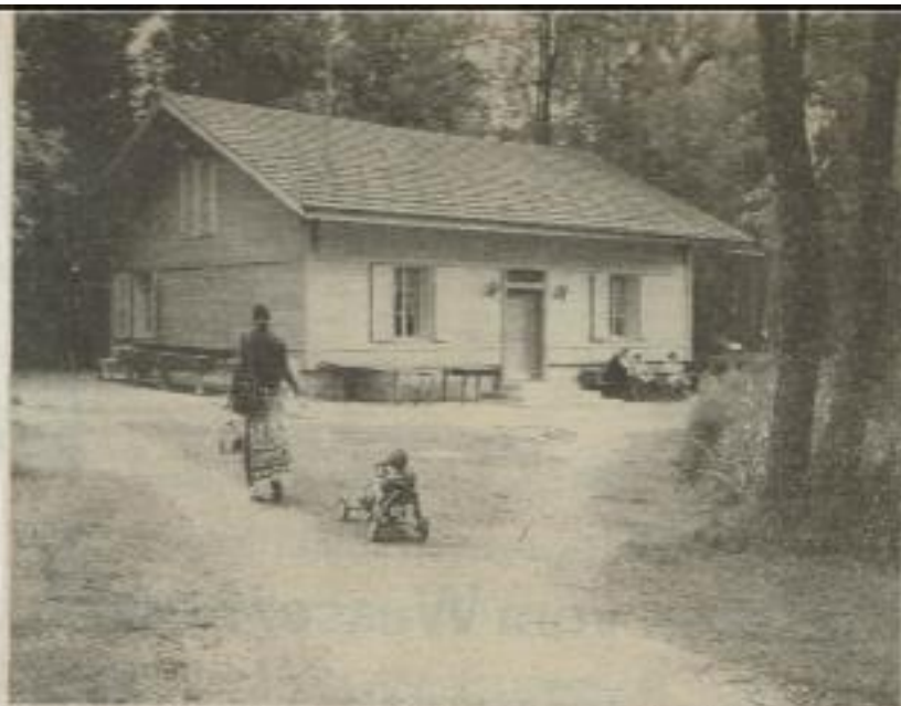
Idylle in der Schosshalde: Kürzlich konnte der 1878 gegründete Schosshalden-Ostring-Murifeld-Leist das vollständig renovierte Leistlokal am Egelsee wiedereröffnen. Der Umbau des 1894 als Bootseinstellraum konzipierten Holzgebäudes war wegen des seewärts abgesackten Fundaments und der morschen Tragkonstruktion nötig geworden. (Bild: P. Wagner)
