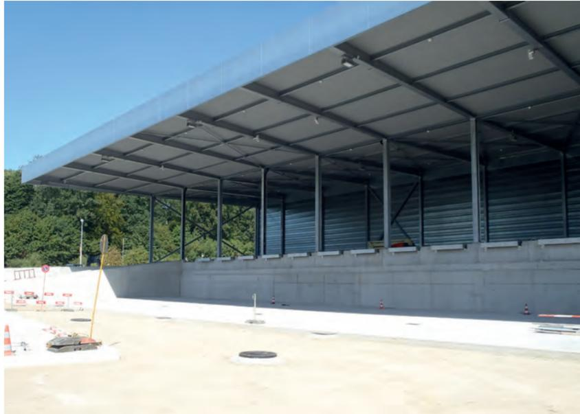
Entsorgungsrampe mit 11 überdachten Ausladeplätzen und eingebauten Waagen an der Brüstung
